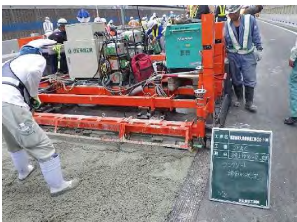
長寿命化対策（SFRC舗装）施工の様子
