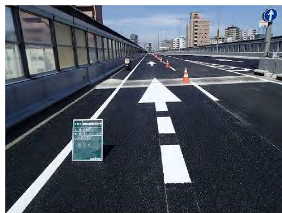
舗装工事施工完了後の様子
