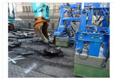
特殊な機械を用いて舗装を撤去する様子
