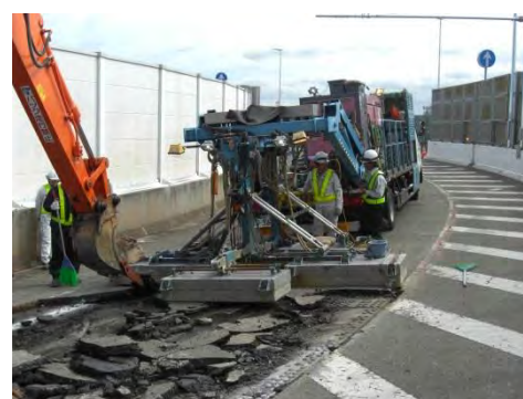
IHヒーターを使用した舗装撤去工法
