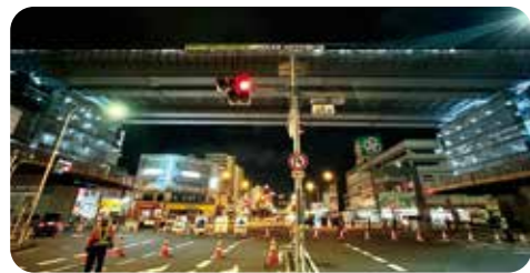
夜間通行止めのうえ仮設桁の引戻し
