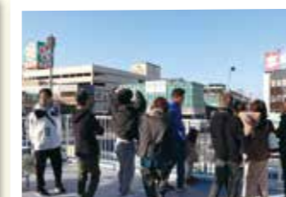
情報館3階屋上より架替え中の橋梁工事の様子を見学
