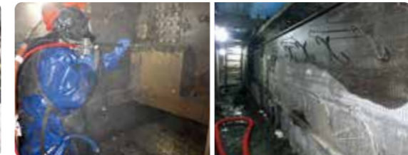
ウォータージェット工法により既設橋脚のコンクリートを削り取ります。
