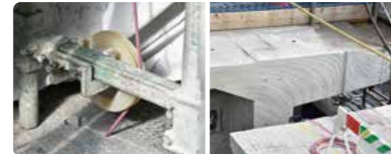
ワイヤーソーによるコンクリート橋脚の切断作業
