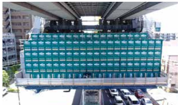
防音資材で覆うことで作業音の低減を図っています。(撮影:2023年4月)
