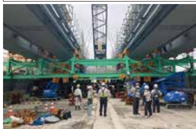
仮設桁に設置した作業用クレーン
