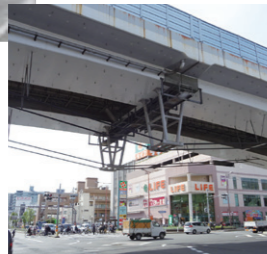
ヒンジ部※を中心にして徐々に橋桁が垂れ下がる ※桁と桁をつなぐ回転機能を有する装置
