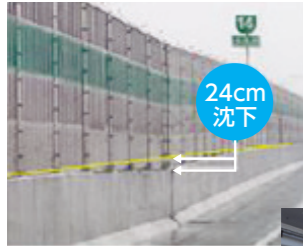
ヒンジ部※を中心にして徐々に橋桁が垂れ下がる ※桁と桁をつなぐ回転機能を有する装置
