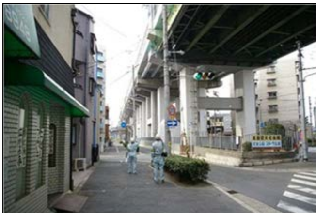
日常点検 路下点検
