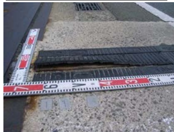
伸縮継手補修工事
