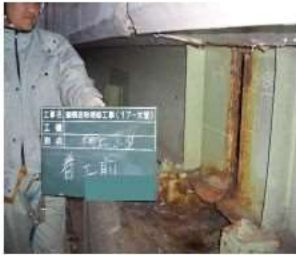
鋼桁部の損傷 (漏水による腐食)
