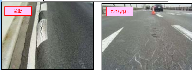
舗装補修工事
