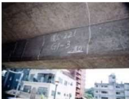
コンクリート桁の損傷(ひび割れ)
