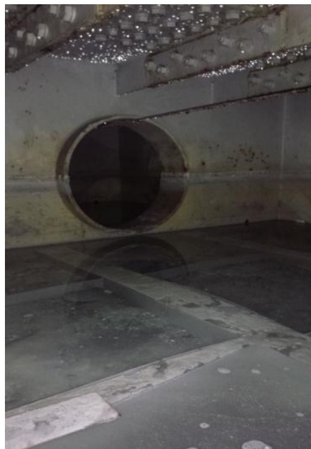
湊町鋼製 フーチング
