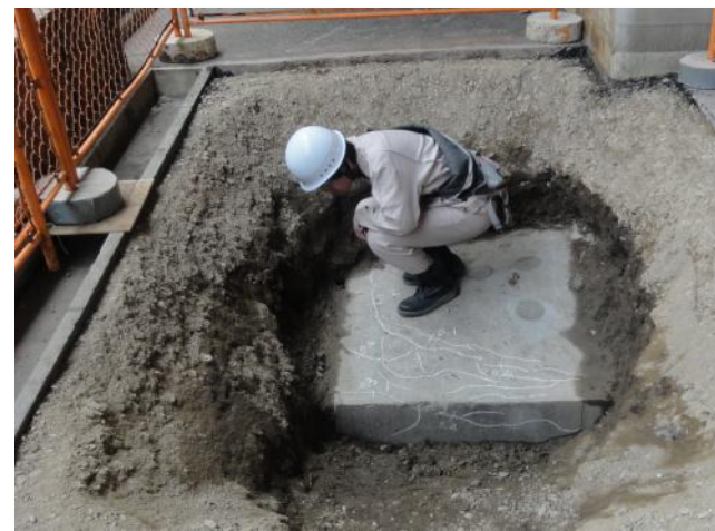
A S R橋脚 基礎調査
