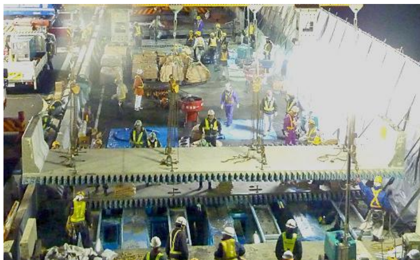
工場製作品(プレキャスト床版)の活用事例
