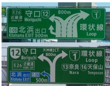
案内標識のレイアウト改良(天神橋 JCT 手前)
