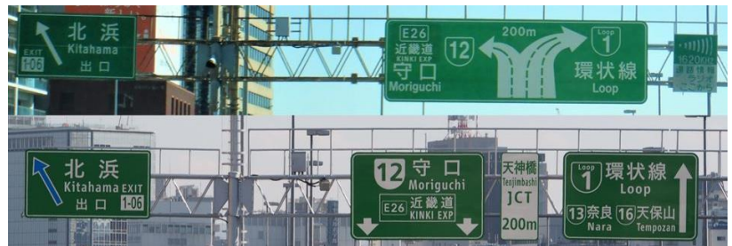
案内標識のレイアウト改良(天神橋 JCT 手前)
