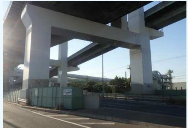
橋脚の塗装による美装化(北港JCT付近)
