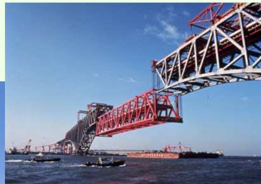
吊桁部の一括吊上げ架設
