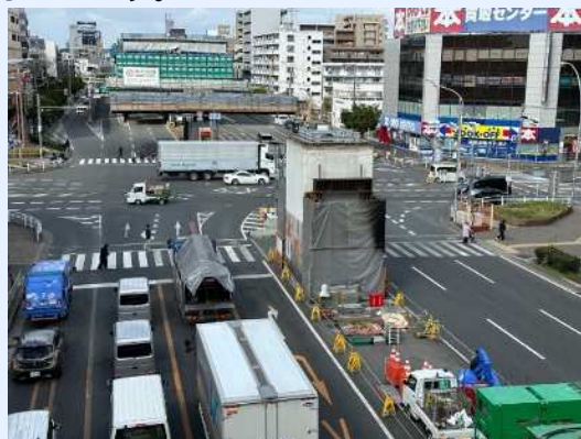
南側の中間橋脚の足場を解体し 柱だけの姿となりました
