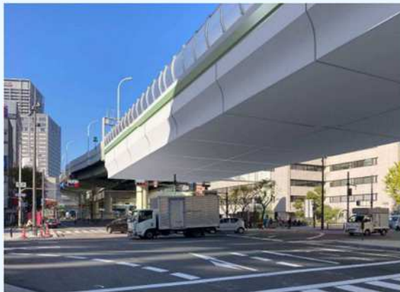
景観に配慮した維持管理施設(難波交差点)
