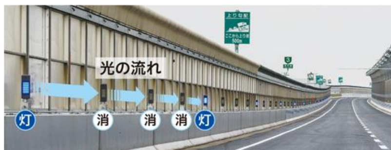
3号神戸線(東行き)深江サグ付近
