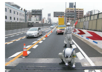
路上点検の様子
