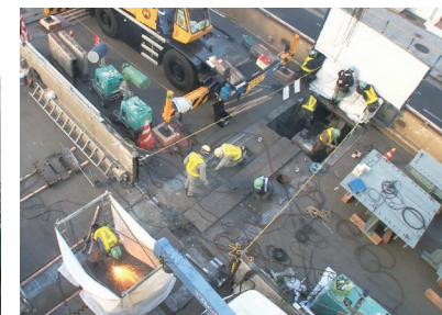
大規模な桁交換などの改良工事を実施
