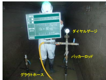
パッカー工法状況例
