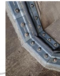
可とう継手の例
