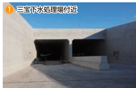
1 三宝下水処理場付近 高速道路本体の工事が完了しました。
