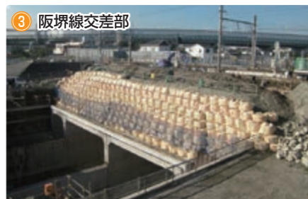
3 阪堺線交差部 トンネル上面の復旧工事をしています。
