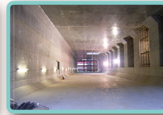
開削トンネル
