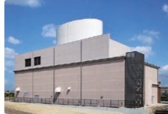
浅香山換気所の建物が完成しています。
