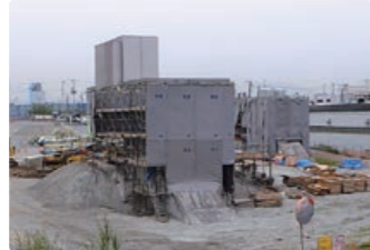
非常口の建屋を造っています。
