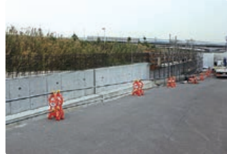
鉄砲東出入口の擁壁を造っています。
