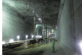
トンネル本線を造っています。
