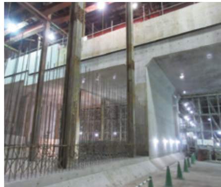
トンネル本線
