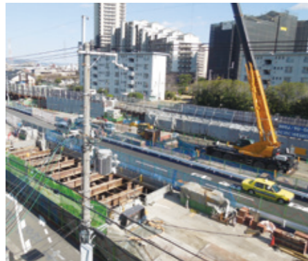
常磐町 地上部
