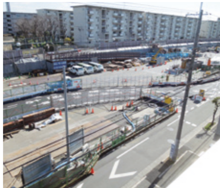
常磐町 地上部
