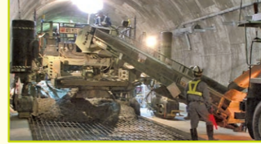
舗装工事の様子
