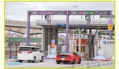
全線開通した大和川線[鉄砲(東行)料金所]
