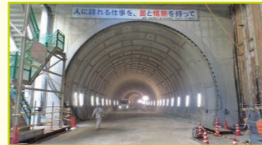
シールドトンネル完成
