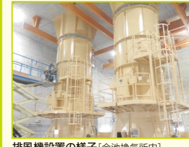
排風機設置の様子[今池換気所内]
