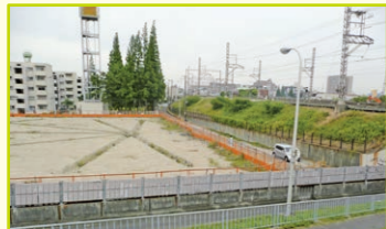
トンネル工事着工前の様子
