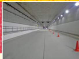
開削トンネル
