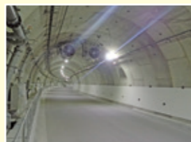
シールドトンネル
