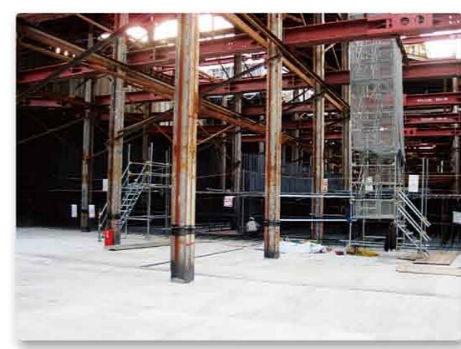
▲ 松屋大和川通《臨海線西側》 掘削が完了し、開削トンネルの床部分を作るための準備をしています。
