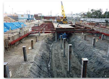
▲ 七道東町《紀州街道付近》 埋蔵文化財調査が終わり、構造物を造るための掘削を行っています。
