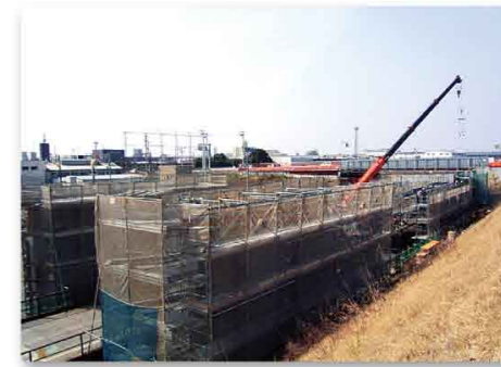
▲ 遠里小野町《和泉泉南線東側》 開削トンネル開口部の本体構造物を造っています。
