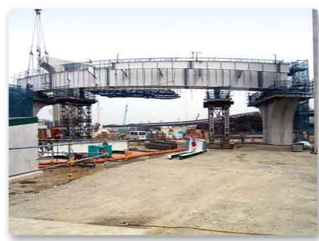
▲ 築港八幡町《4号湾岸線西側》 仮設の支柱を立て、その上に橋桁を架設しています。
