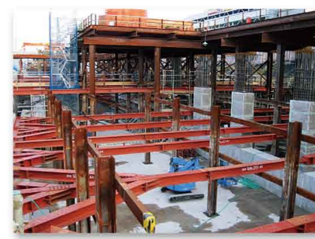
▲ 南島町《国道26号線西側》 開削トンネルの床や柱の一部が出来上がってきました。
