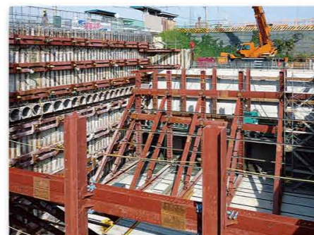
▲ 阪堺線立体交差部《阪堺電気軌道(株)が施工》
