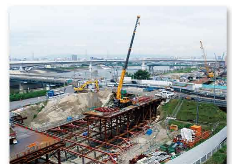
▲南島町《国道26号西側》 国道26号の下の掘削を進めています。
