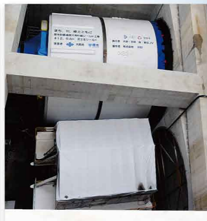
▲シールドマシン組み立て状況(No.5立坑内)
