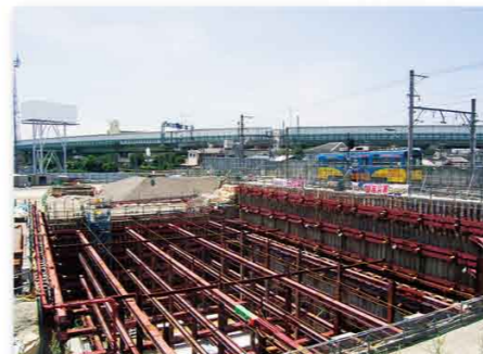
▲阪堺電軌交差点《阪堺電気軌道(株)が施工》 軌道の下へ押し込むトンネル本体を設置するスペースが掘りあがりました。
