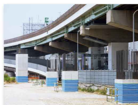
▲築港八幡町《4号湾岸線西側》 三宝出入口を通行止し、三宝ジャンクションの建設工事を進めています。
