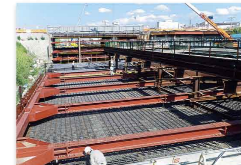
▲遠里小野町《大阪和泉泉南線西側》 大阪和泉泉南線の下で、トンネル本体を造っています。
