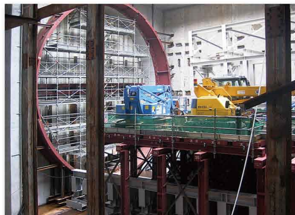
▲シールドマシン組み立て状況(No.1立坑内)
