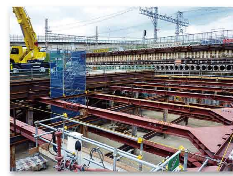
▲南海本線交差部《南海電鉄(株)が施工》 トンネル本体を軌道の下に押し込むためのスペース(立坑)を掘っています。
