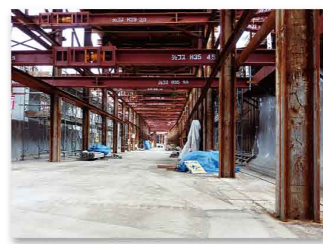
▲鉄砲町《国道26号東側》 トンネルの下面が一部完成し、壁を立ち上げるための鉄筋を組んでいます。
