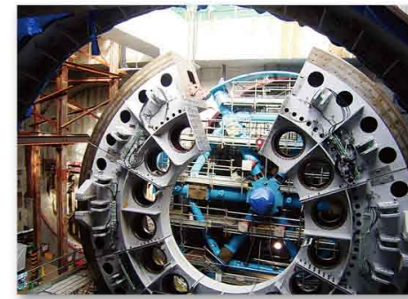
▲遠里小野町《南海高野線西側》 シールドマシンを現場に搬入し組み立てています。ここからマシンが発進します。
