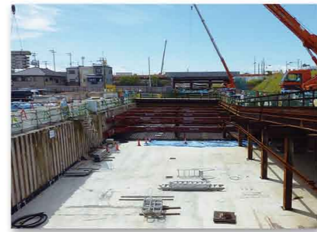
▲遠里小野町《大阪和泉泉南線東側》 トンネルが一部完成しています。写真奥ではトンネル天井部の鉄筋を組んでいます。
