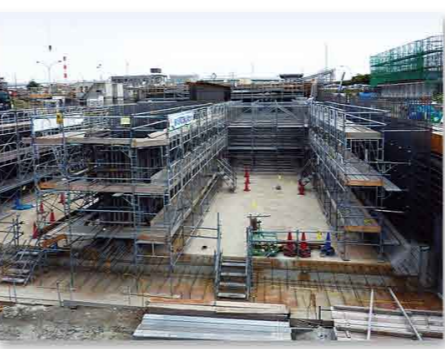
▲松屋大和川通《臨海線西側》 トンネルの壁を立ち上げるための型枠を組んでいます。
