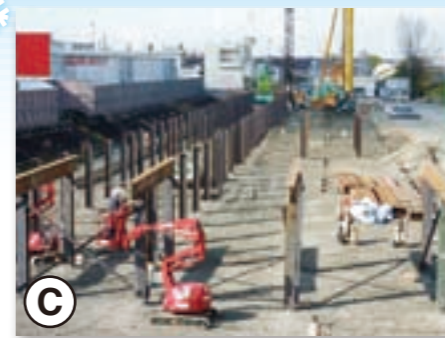
C ▲ 三宝第4工区 - その1 (国道26号西側) 土留壁が完成し、掘削機械やダンプトラックが載って作業する土台(栈橋)を造っています。
