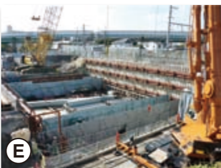
E ▲ 阪堺線立体交差工区 (阪堺電気軌道線が施工) 軌道の下に水平ルーフと呼ばれるトンネル壁を造るための部材を押し込んでいます。
