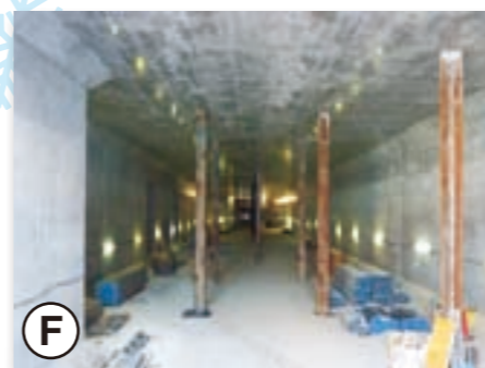
F ▲ 遠里小野第1工区 (阪堺電気軌道線～大阪和泉南線区間) コンクリートが打ち終わり、トンネル構造物の姿が現れました。ここを車が走ります。
