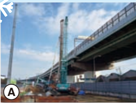
A ▲ 三宝第1工区 (4号湾岸線西側) 湾岸線から大和川線に接続する場所です。橋脚を支える杭を地中に埋め込んでいます。
