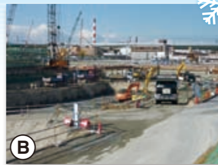
B ▲ 三宝第2工区 (三宝下水処理場付近) 地面を掘り下げた時に、周辺の地面が崩れないように土留壁を造っています。
