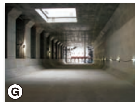
G ▲ 遠里小野第2工区 (大阪和泉南線～南海高野線区間) コンクリートが打ち終わり、トンネル構造物の姿が現れました。ここを車が走ります。
