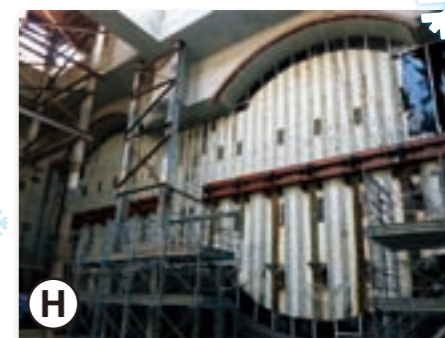
H ▲ 大和川線シールドトンネル (遠里小野立坑) ここからシールドマシンによりトンネルを造ります。マシン搬入前の準備中です。
