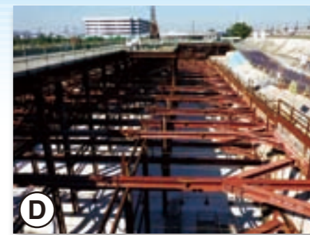
D ▲ 三宝第4工区 - その2 (国道26号東側) 地面の掘り下げを終え、トンネルの底の部分を作っています。
