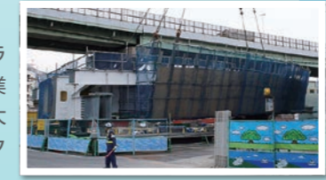
地上で組み立てた、重量130t、全長45mの鋼桁
