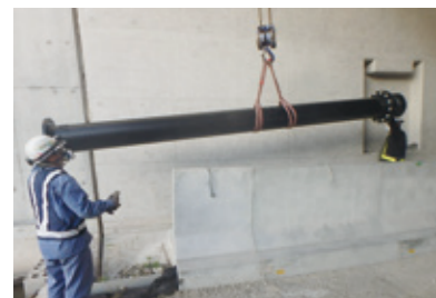
消火配管工事
