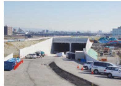
トンネル坑口
