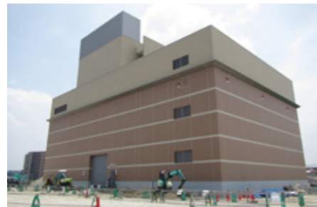
南島換気所の建物部分が完成しました。
