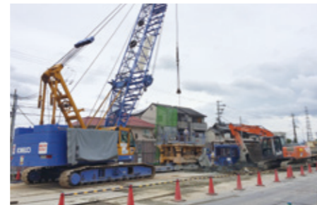
道路を切り回して西除川の旧護岸堤防を撤去しています。
