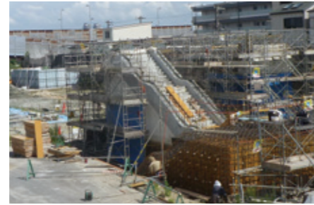
臨海線西側の非常階段を作っています。
