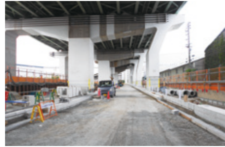
湾岸線の路下整備を行っています。
