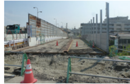
臨海線復旧に向けた盛土の撤去工事を行っています。
