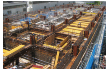
遠里小野換気所の建物地下部分の建設を行っています。
