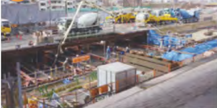
トンネルの天井となる部分を作っています。
