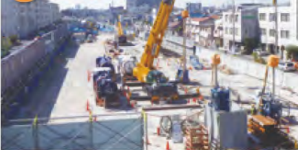
本線部の土留壁工事が完了しました。
