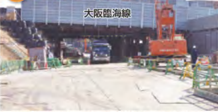
大阪臨海線の下で工事を進めています。
