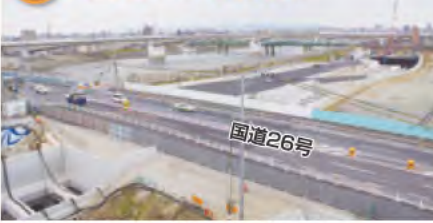
国道26号の復旧が完了しました。
