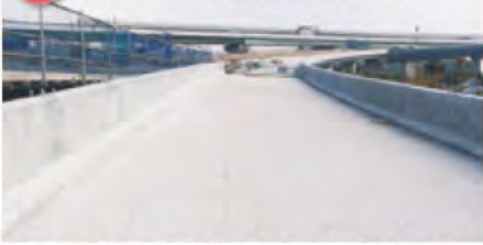
橋の床部分の作業が進んでいます。
