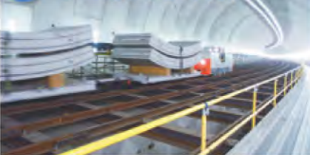
シールドマシンは約1km掘り進んでいます。
