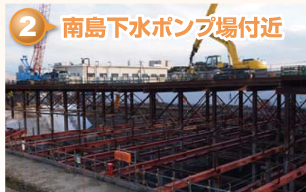
2 南島下水ポンプ場付近
