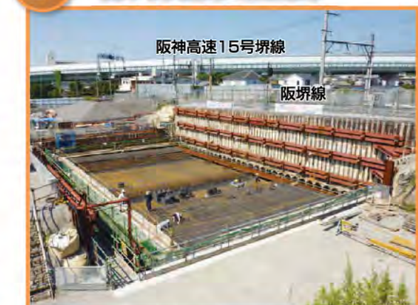
この現場でも南海本線交差点と同様に「R&C工法」を用いて、営業中の阪堺線の下にトンネルをくぐらせる工事を進めています。
