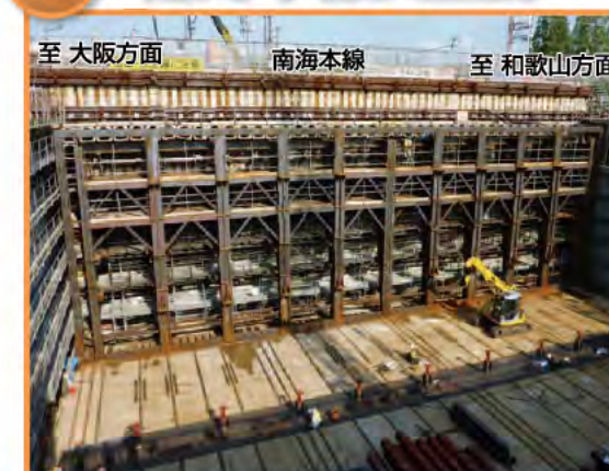
事前に造ったトンネルを移動させて線路の下にくぐらせる「R&C工法」を用いて、南海本線の営業を維持しながらトンネルを交差させる工事を進めています。
