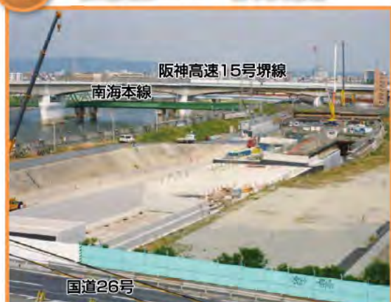
この付近は掘削構造となっており、構造物がほぼ完成しました。今後、国道26号とつながるランプの工事を進めていきます。
