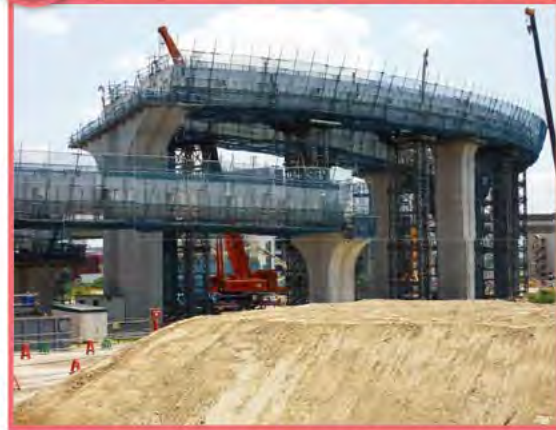
この現場では三宝ジャンクションの建設が進んでおり、次々に橋脚が立ち上がり、橋桁を架設しています。
