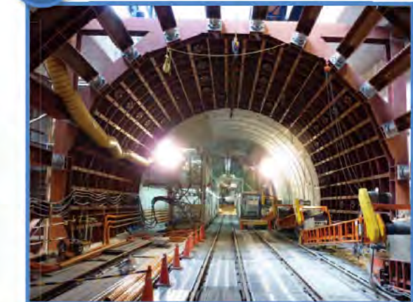
平成24年3月末にマシンが発進して以来、着実にトンネルを掘り進めています。現在は南海高野線交差点を超え、常磐町方面に向けて進んでいます。
