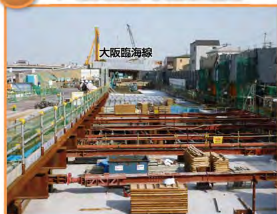
この現場でも開削トンネル工事が進んでいます。大阪臨海線と交差する箇所では、通行する車や人に影響を与えないよう慎重に工事を進めています。
