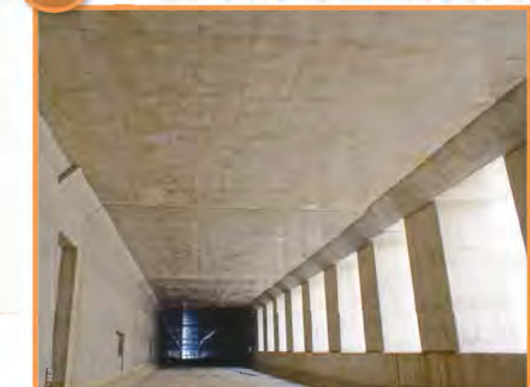
この現場では、トンネルがほぼ完成しました。現在は、大阪和泉泉南線付近の埋め戻しを行っています。
