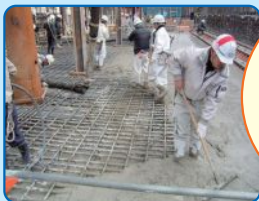
コンクリート打ち込み状況
