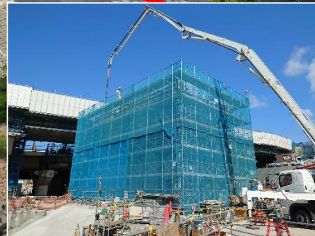
③換気塔部の躯体工
