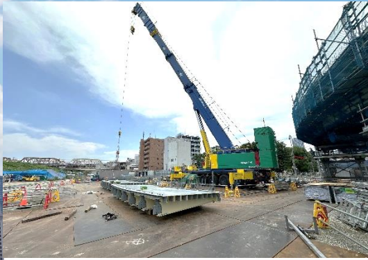
①桁・側床版架設工
