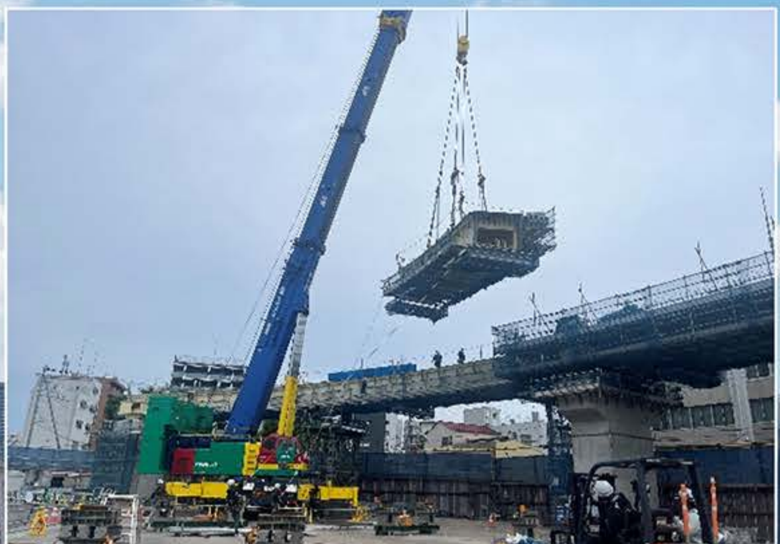
①桁架設工
