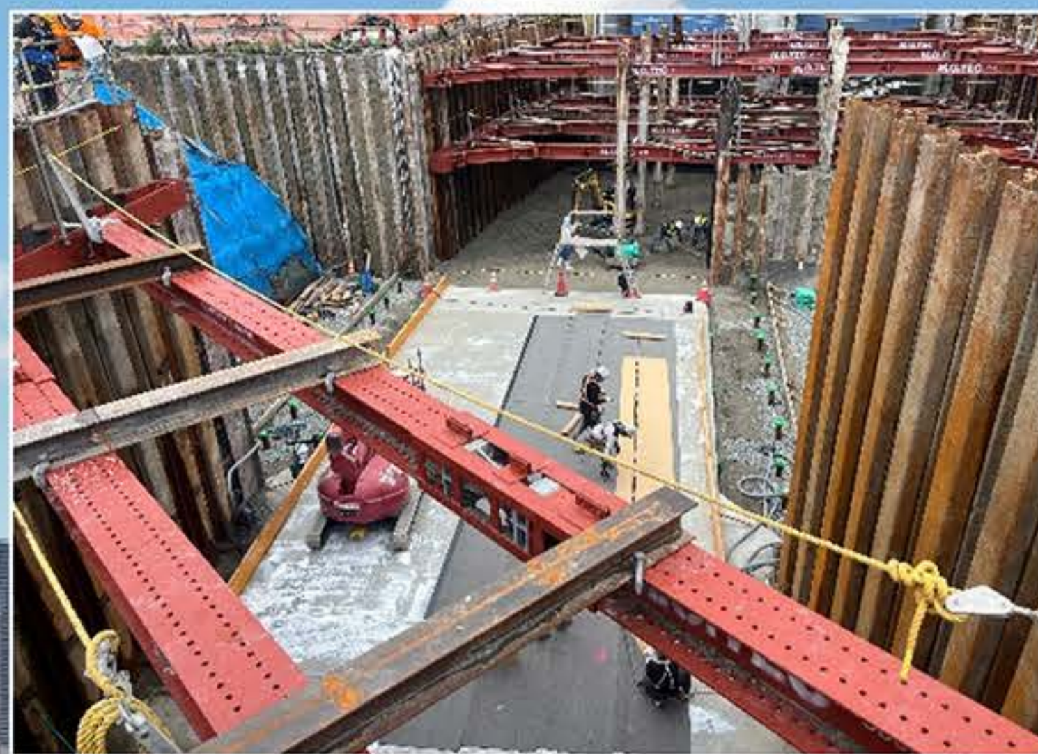
②擁壁部の防水工
