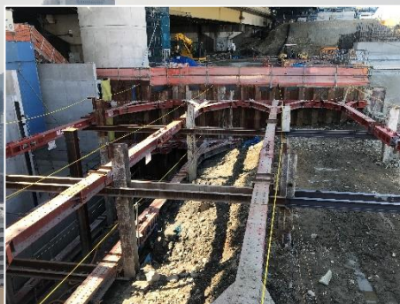
②擁壁部の掘削工
