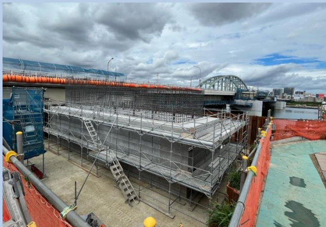
①橋脚柱部の構築
