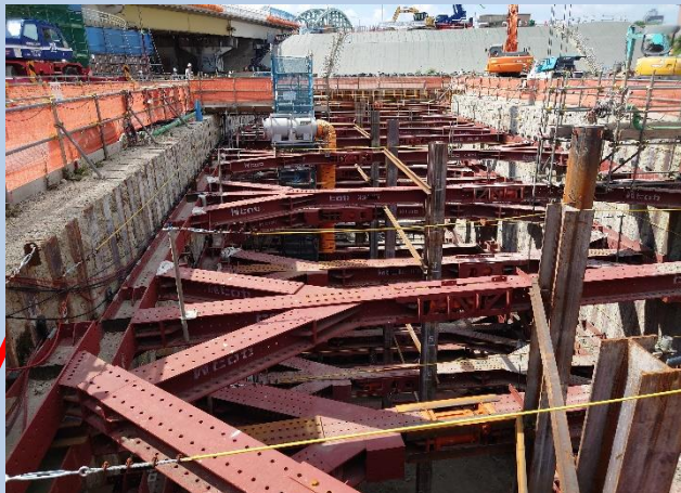
②換気塔部の掘削・土留支保工
