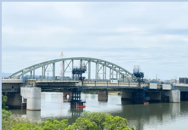
①河川上の桁架設
