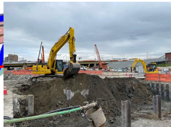
④受電所部の掘削・土留支保工
