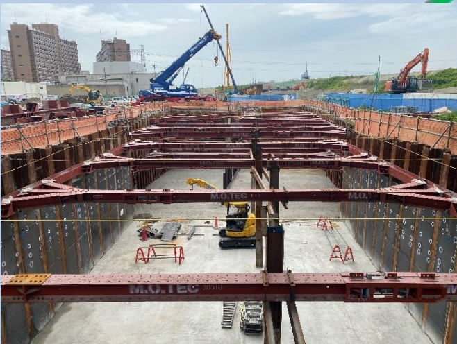
③擁壁部の均しコンクリート打設
