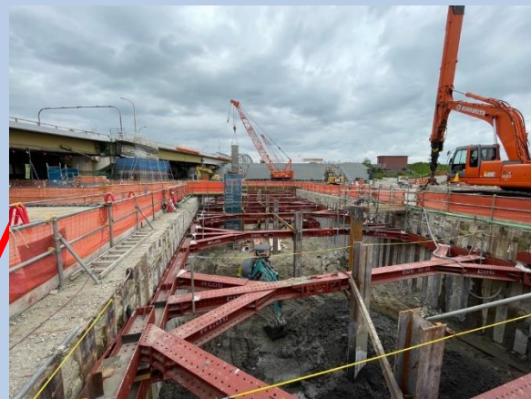
②換気塔部の掘削・土留支保工
