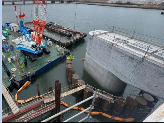
①鋼管矢板撤去工
