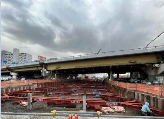
③擁壁部掘削・土留支保工
