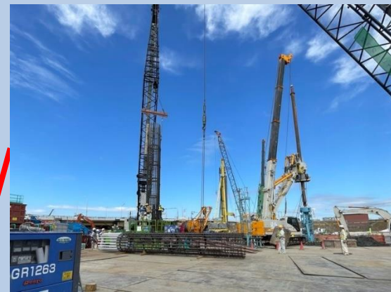
②杭の施工
