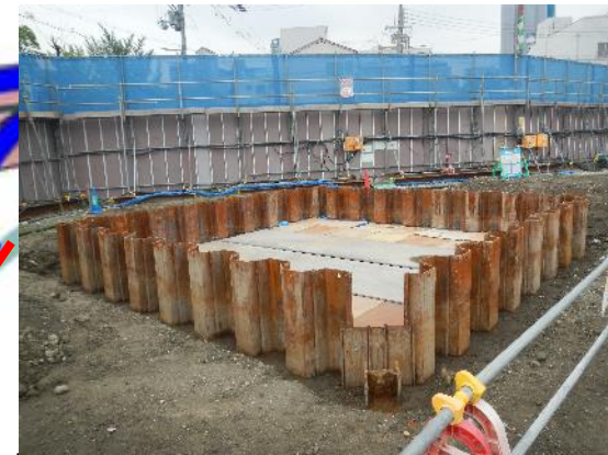
④橋脚基礎の施工
