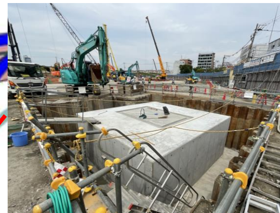
橋脚基礎の施工
