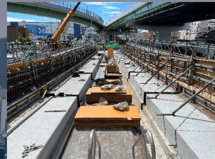
②擁壁の施工
