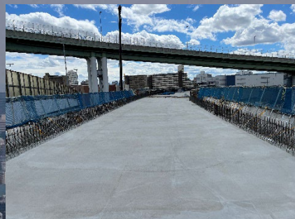
①床版の施工
