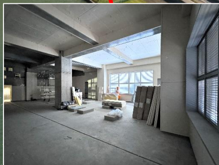
③換気所内外装の仕上げ
