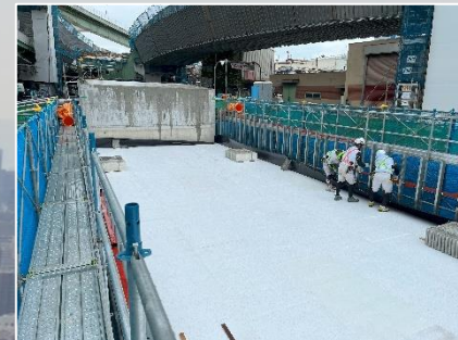
②擁壁の施工
