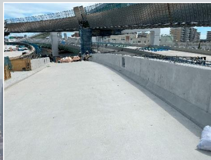
①高欄の施工
