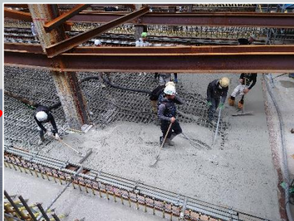
④底版コンクリートの打設
