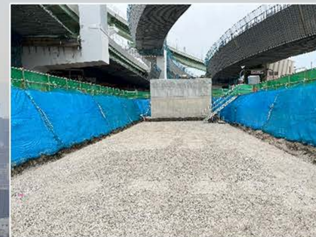
②擁壁の施工
