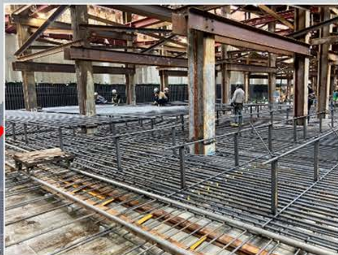
④底版コンクリートの型枠組立
