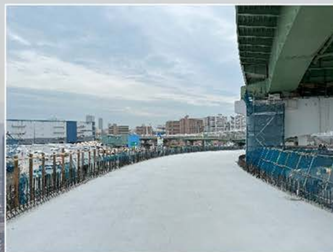
①床版の施工
