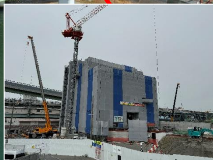
③換気所5階部の構築
