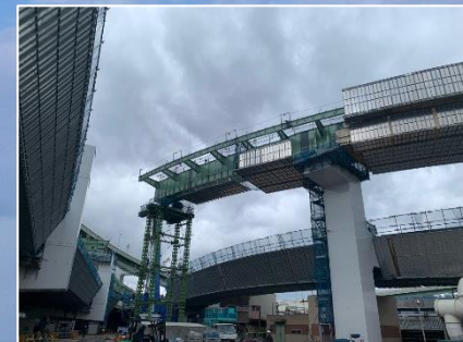
①橋桁の設置
