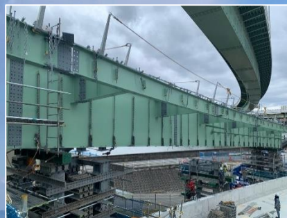
②橋桁の設置
