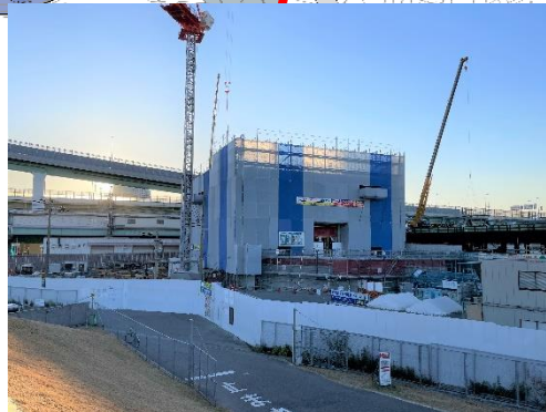
④換気所2階部の構築
