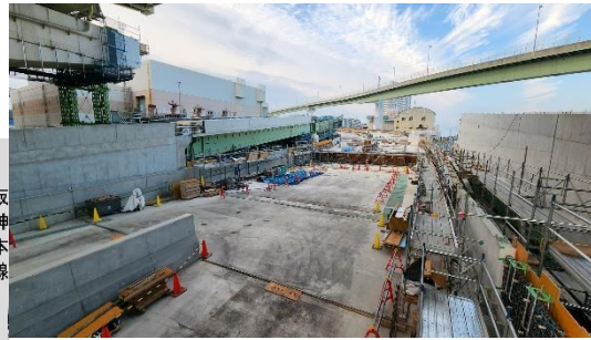
②掘割擁壁部の構築
