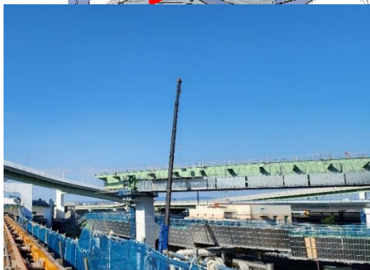
④橋桁の設置
