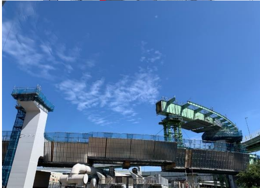
④橋桁の設置
